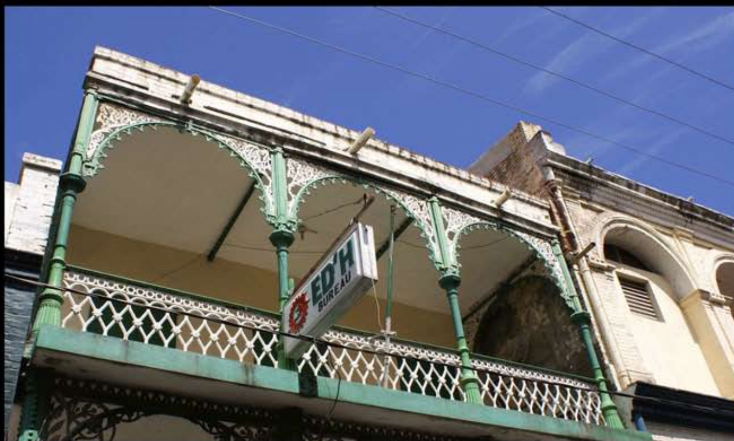
La galerie haute en fer et fonte
