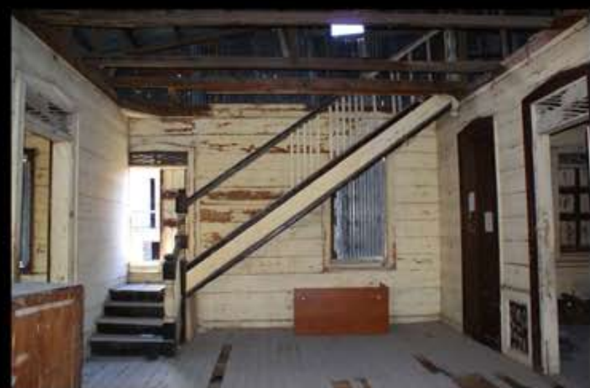
L'escalier d'accès au comble habitable
