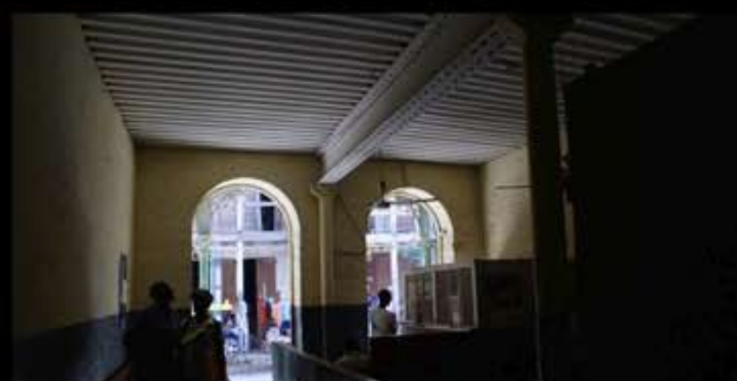
La halle réaménagée en bureau
