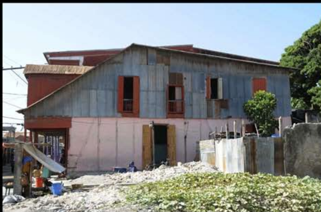
La façade latérale Nord
