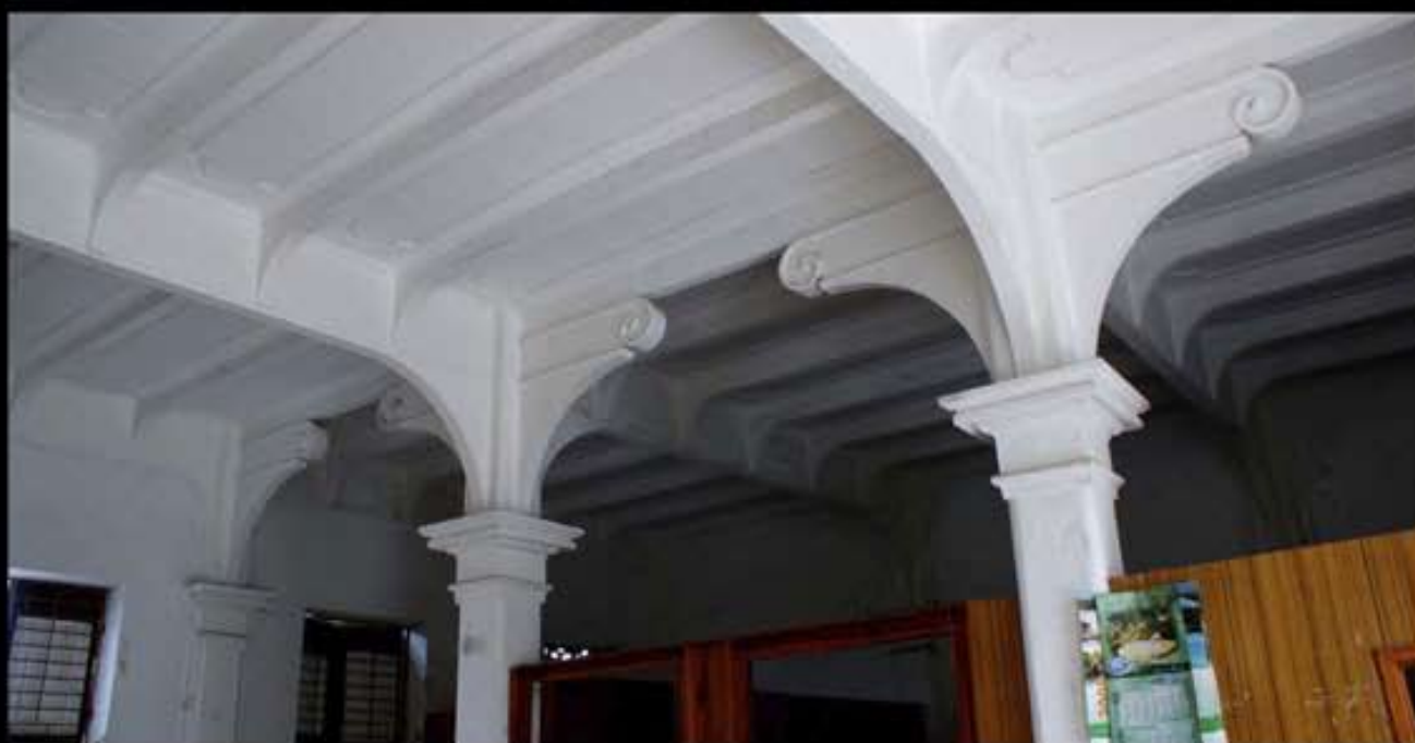
Le plafond à caissons de l'étage
