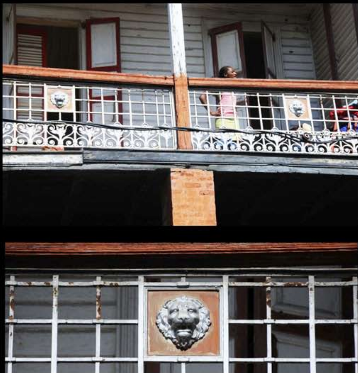
Détail du parapet de la galerie haute
