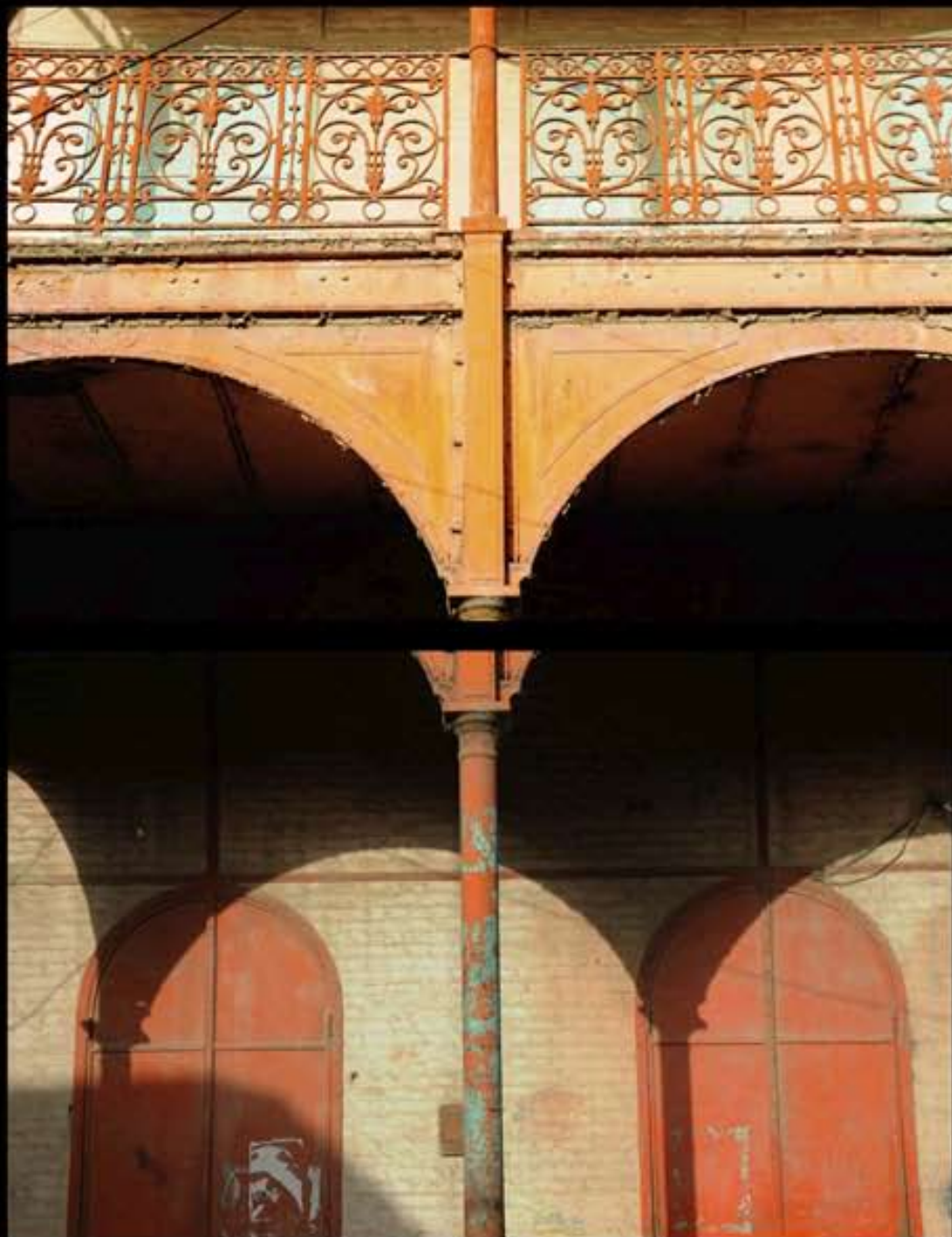
Eléments architecturaux en fer et fonte appliqués à la façade
