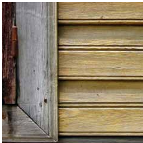
• 33 : Certaines maisons gingerbread sont dotées de panneaux extérieurs en planches ainsi qu'un revêtement intérieur en bois.
