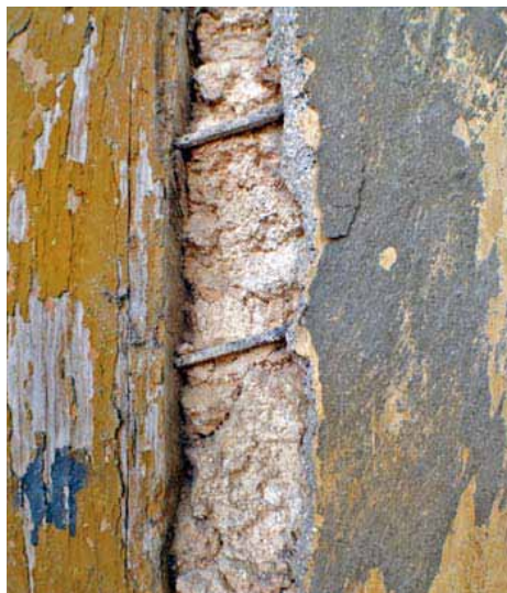
• 43 : Des clous aident à contenir le hourdage en terre crue.
