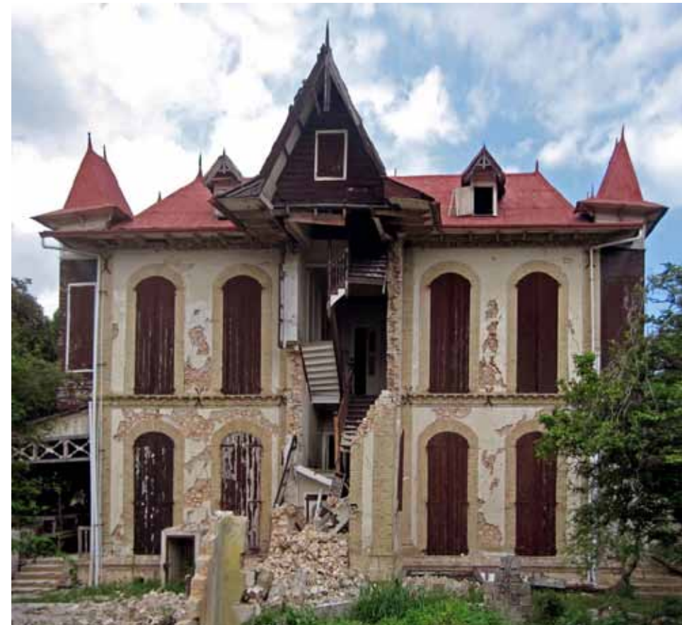
• 47 : Vue de l'élévation arrière du Castel Fleuri. L'utilisation d'une maçonnerie en briques autour des fenêtres, dans les angles et à la base du plancher, en tandem avec le stuc à la chaux qui recouvre ailleurs la maçonnerie de moellons, crée une attrayante composition. A noter les plaques de fond en X des tringles en fer visibles sur la façade qui, dans ce cas, n'ont cependant pas été installées dans les angles de l'édifice.
