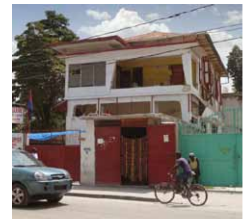
• 22: Un ajout en ciment au no. 4 de l'avenue Christophe dissimule complètement cette bâtisse qui perd ainsi son identité originale de maison gingerbread.
