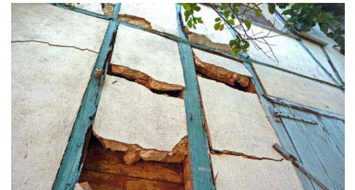
• 39 : Colombage au 5 de la rue José Martí avec hourdage de pierres calcaires et torchis de terre et un enduit composé de plâtre et de chaux. On remarque le revêtement intérieur en planches.
