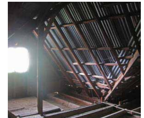
• 58 : La charpente en bois et l'espacement des pannes sablières de ce grenier ne peut accommoder qu'une toiture en feuilles de tôles ondulées, indication que les matériaux de ce toit sont des originaux.
