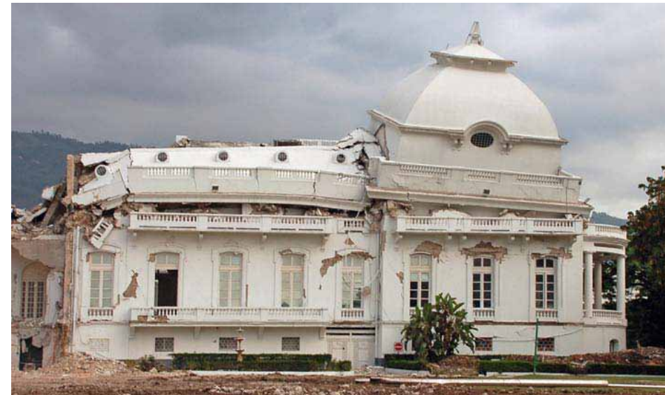
• 28 : Le Palais National, construit en 1918, est un exemple de l'utilisation précoce du béton armé en Haïti. Ces constructions se sont tout ou en partie effondrées.
