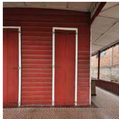
• 34 : La maison sise au 24, avenue Lamartinière montre les caractéristiques des panneaux de contreplaqué superposés des gingerbread à charpente en bois entretoisé, ainsi que la simplicité des portes dénuées de décorations répandues dans toutes les techniques de constructions et le carrelage très voyant de la galerie du rez-de-chaussée.
