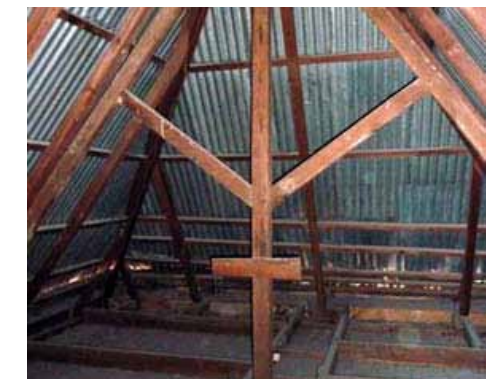
• 54 : Un toit en feuilles de tôles ondulées au-dessus des pannes sablières et la charpente en bois entretoisé.
