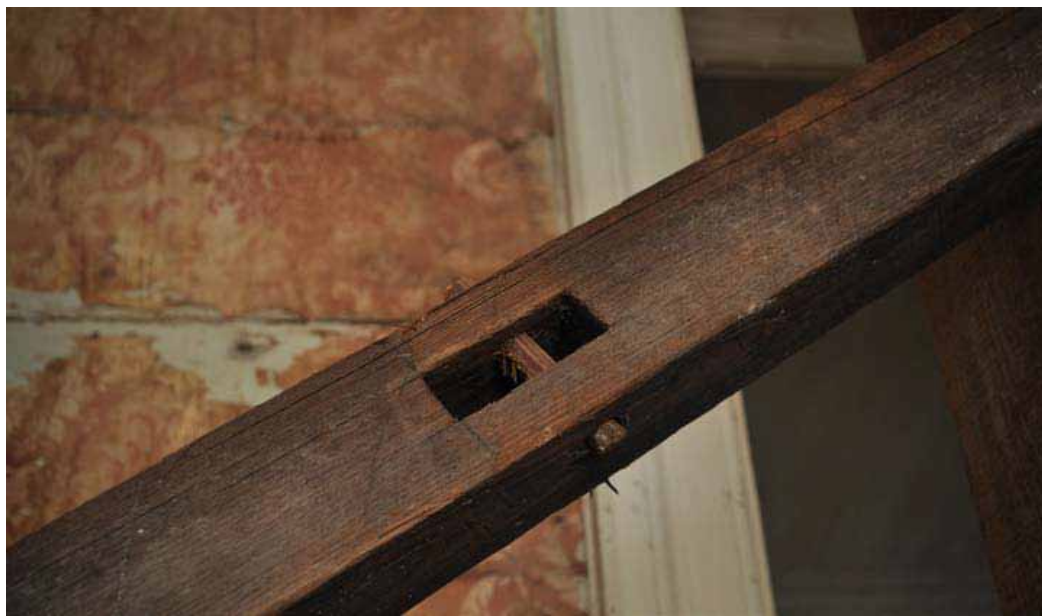
• 32-a : En haut : intérieur d'une pièce construite au-dessus de ce qui reste de la galerie de la maison Pamphile au 4 de la rue Cassés. L'intérieur montre les caractéristiques typiques en Haïti d'une construction en bois de charpente qui se situe quelque part entre les charpentes lourdes assemblées en tenon et mortaise comme dans les constructions en France de l'époque médiévale et de la Renaissance et les charpentes «à pans» de bois sciés plus légers des constructions américaines du XIXème siècle.
