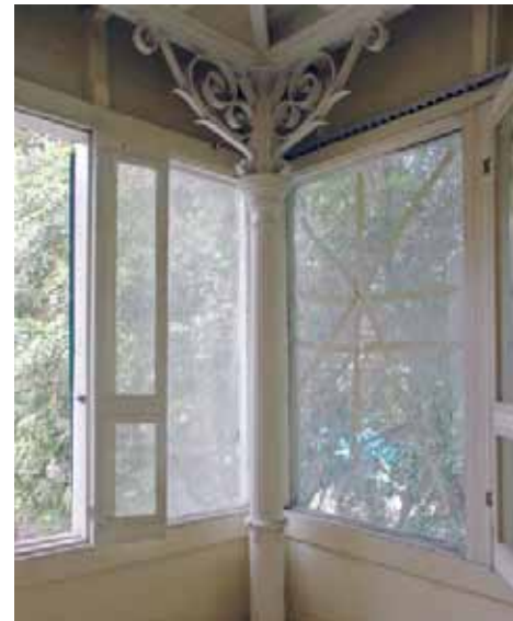
• 27 : Un exemple de motifs artistiques en ferronnerie sur les balcons du deuxième étage du Manoir. Ce travail en fer forgé est masqué par des parois extérieures en bois.
