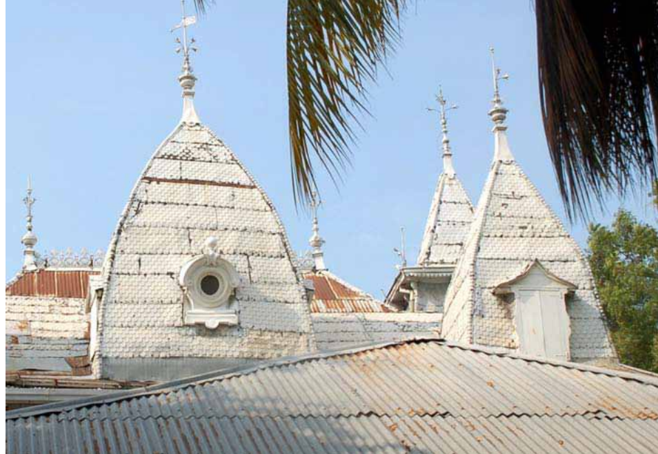
• 56 : Les toits des tourelles du Manoir ont été faits en bardeaux décoratifs de métal embouti.
