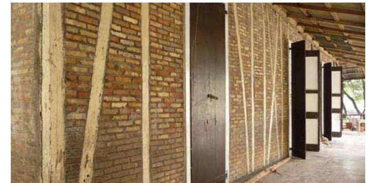
• 38 : Colombage avec hourdage briques et de torchis de chaux au 30 de l'avenue Lamartinière.
