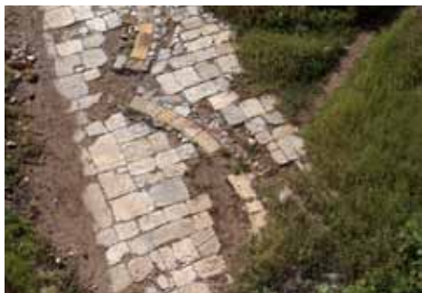
• Pavage en grès de Barzac des batteries
