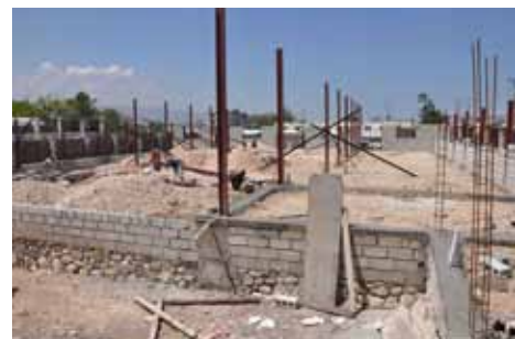
• Vues du chantier au mois de mars 2011
