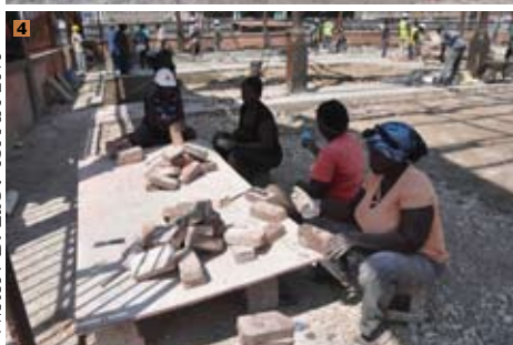
• 1. La nouvelle halle nord et, au fond, la halle sud. • 2. La structure métallique de la halle nord. • 3. Le chantier vu du boulevard Jean-Jacques Dessalines. • 4. Le nettoyage des briques récupérées
