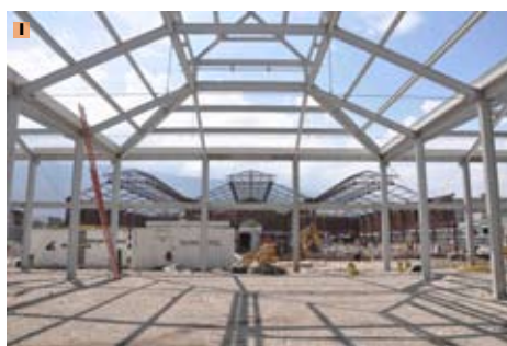
• Le chantier de restauration du Marché Hyppolite : au fond, la structure de la nouvelle halle nord, en avant-plan, la structure historique en cour de restauration
