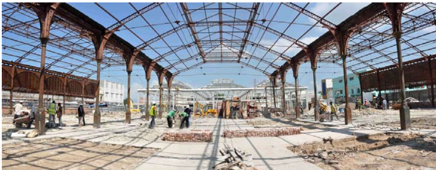
• Le chantier de restauration du Marché Hyppolite : au fond, la structure de la nouvelle halle nord, en avant-plan, la structure historique en cour de restauration
