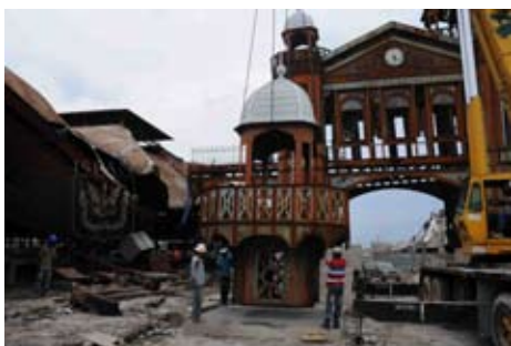
• Dépose d'une des tourelles du pavillon central
