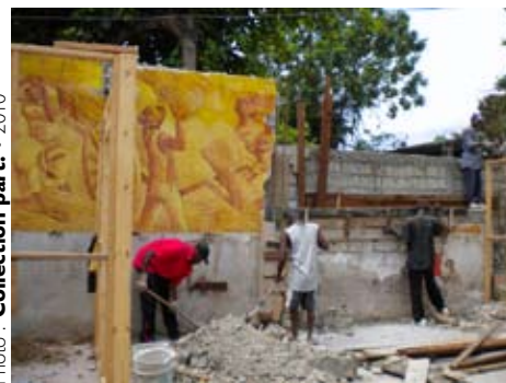
• La démolition de la fresque de Ramponneau
