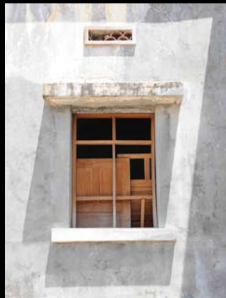
• Une baie de la Mairie
