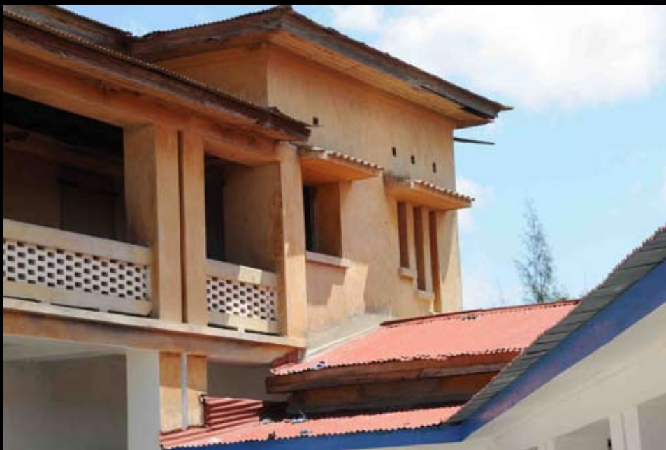
• La coursiue et la cage d'escalier des Casernes
