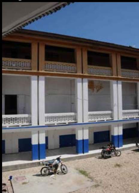
• La façade intérieure des Casernes
