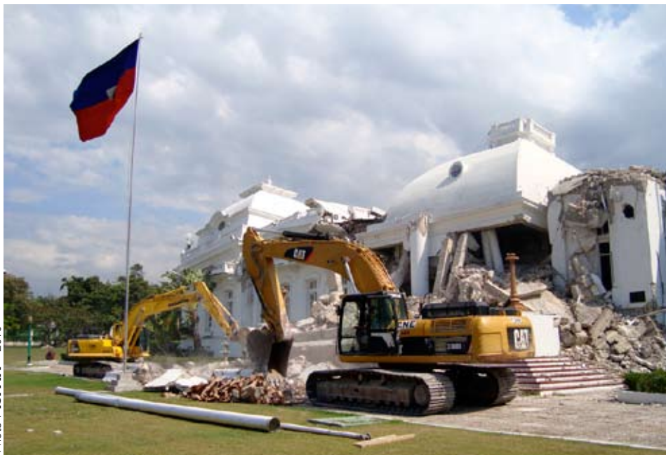
• Dépose des éléments irrécupérables
